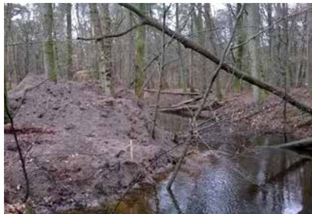
Upes gultnes paaugstināšana, smiltis lēnām ieskalojot upē un ļaujot „ūdenim darīt savu darbu”. 2014. gadā Hīrdensēbēkā [Hierdense beek] (fotogrāfija: Bart Reeze, Stroming BV).
