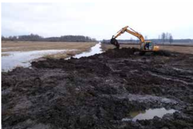
21. att. Pirmā aizbēruma būve atjaunojamā upes posma augštecē (05.03.2015.). Foto: E. Račinskis
