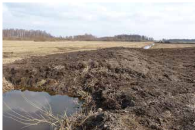
22. att. Pabeigts pirmais aizbērums atjaunojamā upes posma augštecē (25.03.2015.). Foto: E. Račinskis
