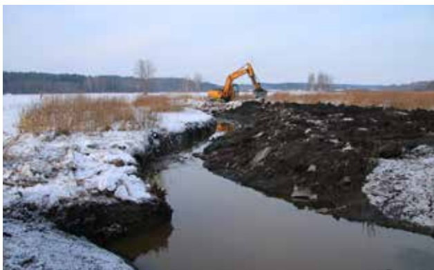
16. att. Rakšanas darbi pārsvarā notika no abiem vecgultnes krastiem (30.01.2015.; attēlā padziļināta tikai puse no atjaunotās upes platuma). Foto: I. Priedniece
