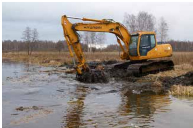
14. att. Bebru dambja novākšana ūdens līmeņa pazemināšanai (14.01.2015.). Foto: E. Račinskis
