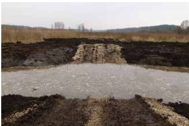
25. att. Nostiprināts brasls upes šķērsošanai ar lauksaimniecības tehniku (25.03.2015.). Foto: E. Račinskis
