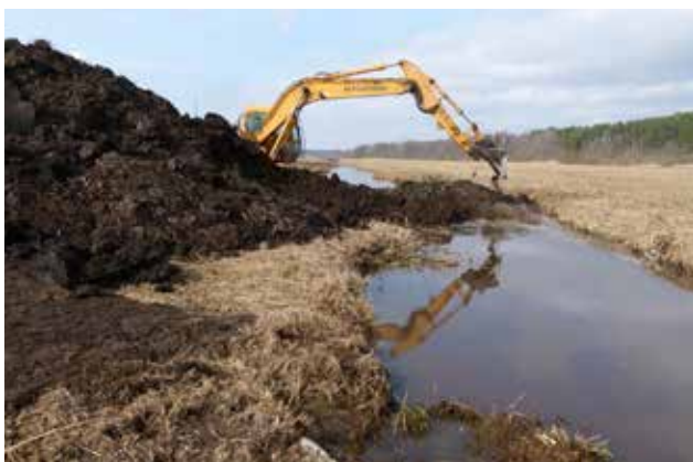
23. att. Otrā aizbēruma būve uz taisnotās upes gultnes (25.03.2015.). Foto: E. Račinskis
